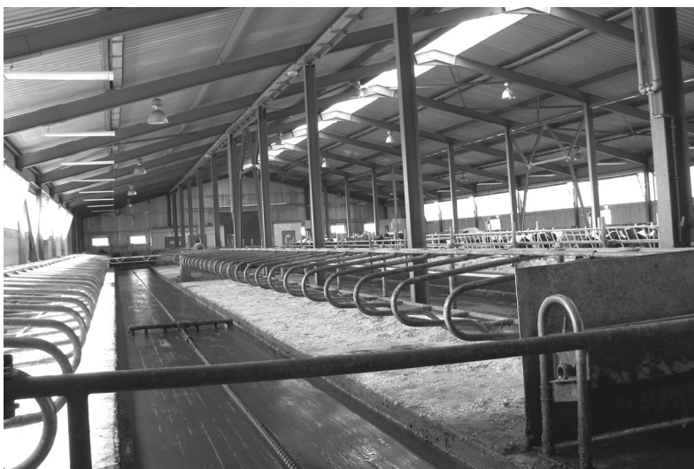
Рис. 4. Слева полы в боксах (бетонные, покрытые полиуретаном) справа полы покрытые резиновыми ковриками)
