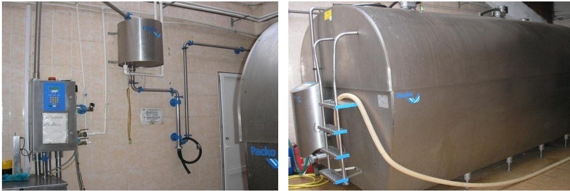
Рисунок 41 – слева - фильтрация молока; справа - танк-охладитель молока
