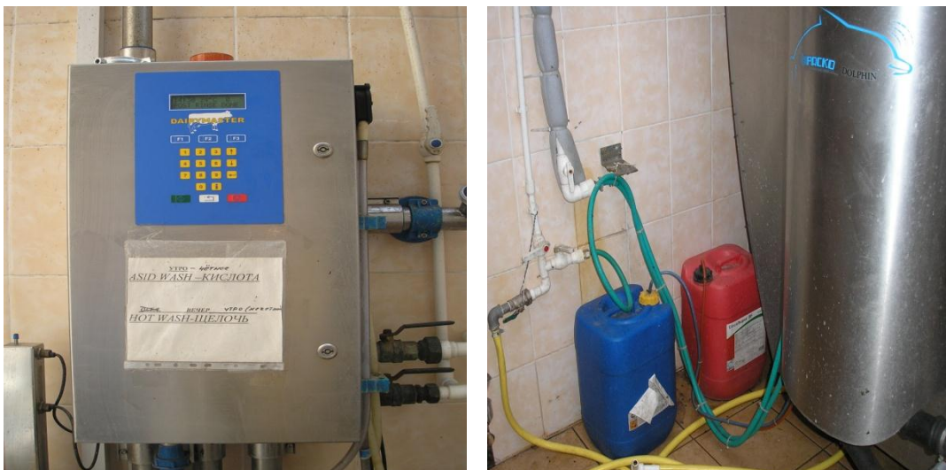
Рисунок 42- слева - система промывки доильной аппаратуры; справа - система промывки танка-охладителя
