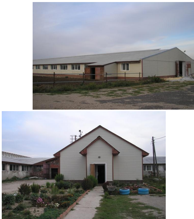
Рисунок 2 - Внешний вид молочного комплекса после реконструкции
