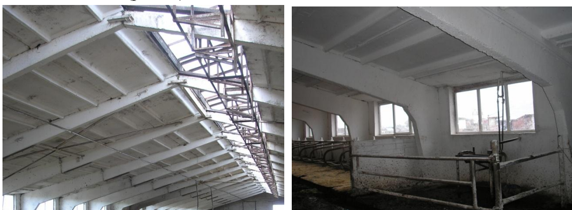
Рисунок 7 – слева - вентиляционный и световой конек в реконструированной крыше; справа - стеклопакеты в окнах
