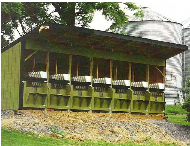
На снимке – односкатный навес на несколько индивидуальных загонов. Снятие задней панели летом позволяет лучше циркулировать воздуху. Перегородки между загонами не позволяют телятам контактировать мордами.
