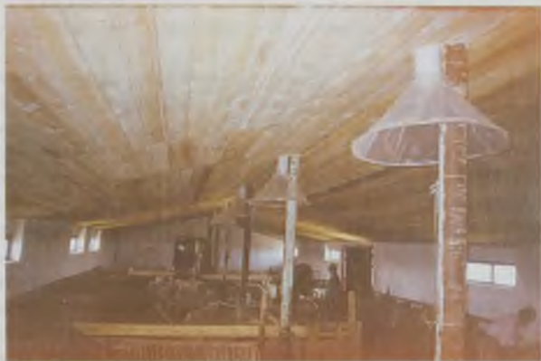
Рисунок 53 – Расположение и устройство вентиляционных шахт
