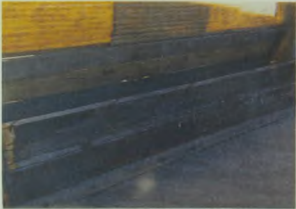
Рисунок 21 – Щит в первоначальном положении. Вид встроенной кормушки со стороны кормового прохода
