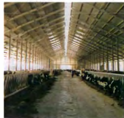
Рис. 12.5. Коровник с коньковой вентиляцией
