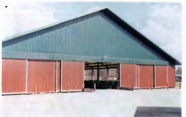
Рис. 12.2. Внешний вид коровника с трансформирующимися стенами
