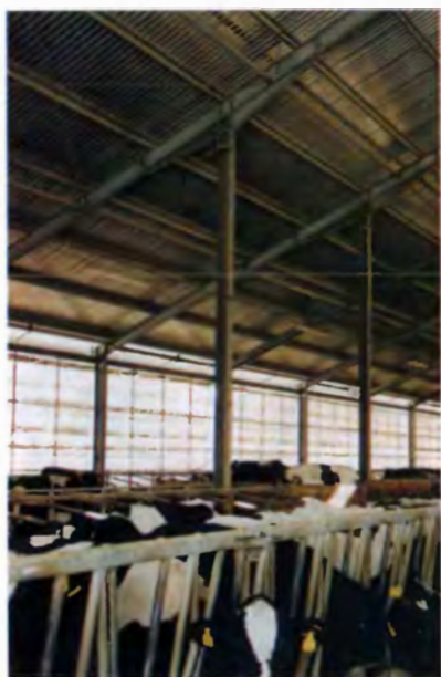
Рис. 12.6. Коровник с высокими боковыми стенами, служащими для освещения и вентиляции помещения
