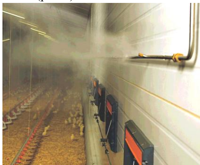
Рис. 8. Система охлаждения (орошения) под высоким давлением «Fogging Cooler» фирмы «Big Dutchman».
