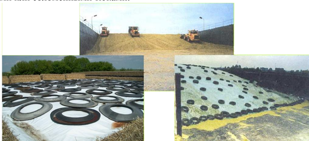
Рисунок 26.3 - Трамбовка и укрытие силоса (GEA Farm Technologies)
